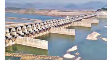
నిర్మాణంలో ఉన్న పోలవరం ప్రాజెక్ట్
